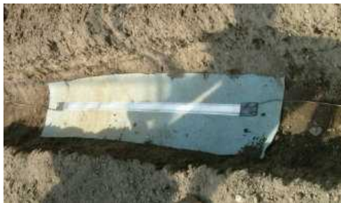
土中埋設風景
