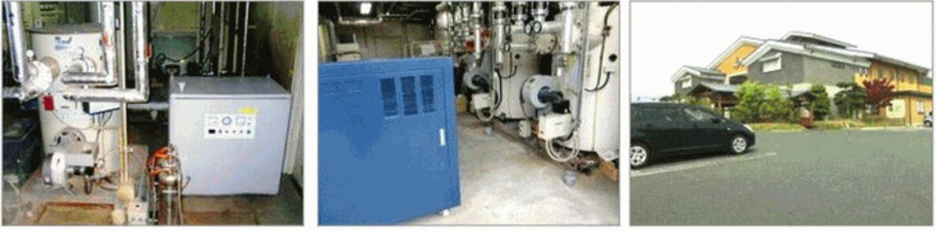
エコエネガスシステム設置後、火炎温度の上昇を以前の温度に合わせるためにノズルを小型化し対応。
